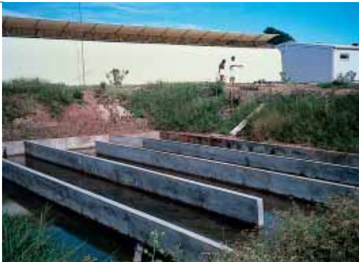
Bassin de décantation des rejets.
