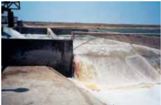
Station de pompage semi-industrielle et filtration de l'eau.
